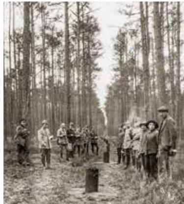
Abb. 13: Aufbau der Nebeltöpfe auf einer Schneise.
