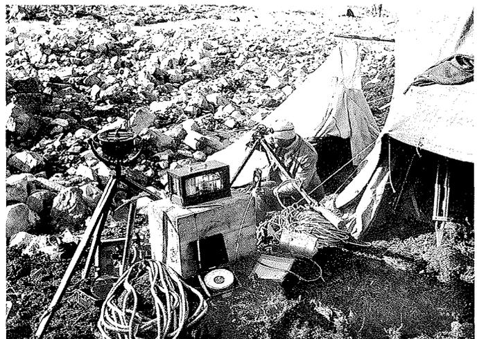
**Abb. 3:** Eine Auswahl an Instrumenten der deutschen Spitzbergen-Expedition (Sommer 1925). Unter anderem erkennt man im Vordergrund ein Dosenbarometer, dahinter einen Barograph auf der Holzkiste, links einen aufgestellten Peilkompaß. Hinter dem Kompaß liegt ein Sextant auf dem Boden. Grotewahl nimmt gerade mit dem Theodolit eine Peilung vor.
